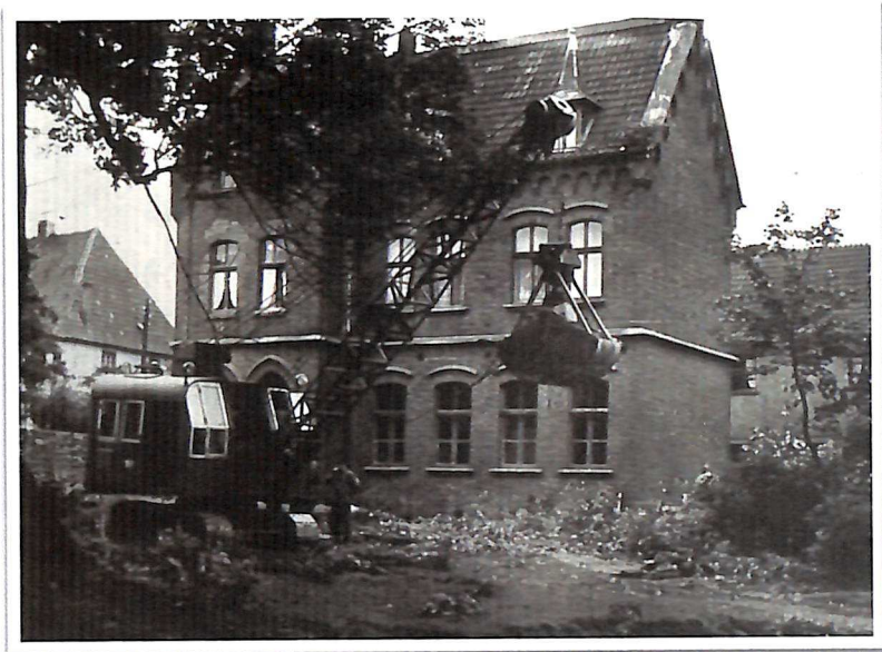
Jüdische Schule (Baujahr nach 1892). Das Haus existiert noch an der Bäckerstraße und ist 1956 erweitert worden. Siehe nebenstehendes Bild. (Stadtarchiv Werl, Akten KB 125 Nr. Dia 59)
