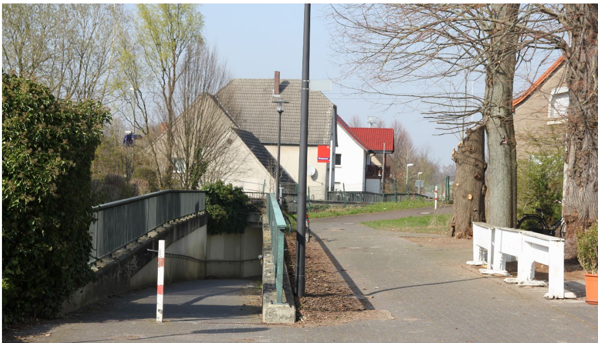
Zugang zum Bahnsteig Richtung Lippstadt (links) und rechts Richtung Paderborn, Quelle: Johannes Theissen
