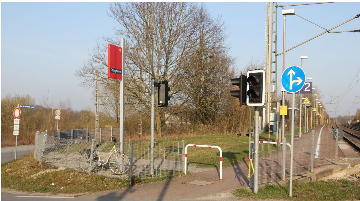
Eingangsbereich zum Bahnsteig Richtung Lippstadt - Soest, Quelle: Johannes Theißen
