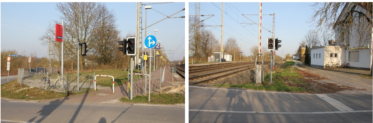
ABBILDUNG 34: ZUGANG ZUM BAHNSTEIG RICHTUNG SOEST (LINKS) UND FREIFLÄCHEN AUF DER GEGENÜBERLIEGENDEN SEITE (RECHTS)
