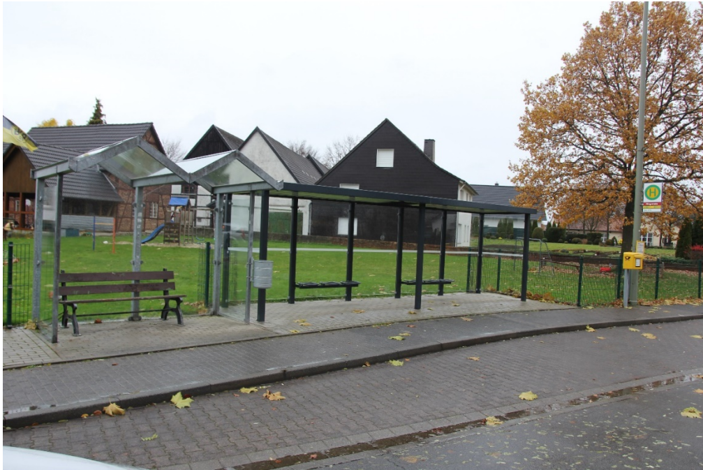
ABBILDUNG 93: GROSZÜGIG AUSGEBAUTE BUSHALTESTELLE „RINGSTRASSE“ IN STIRPE MIT FAHRRADBÜGELN (LINKS NEBEN DEN WARTEHALLEN)
