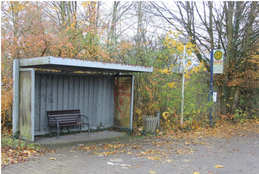
ABBILDUNG 86: HALTESTELLE „KRANKENHAUS“ IN WIMBERN
