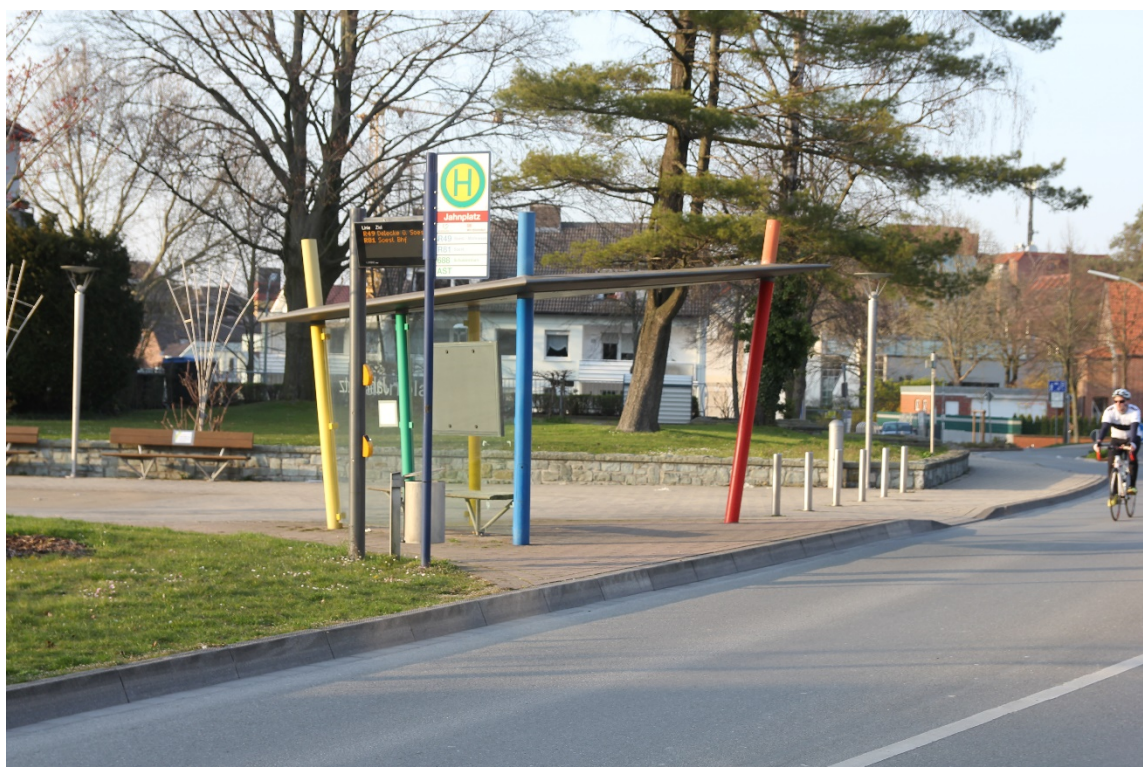
ABBILDUNG 82: HALTESTELLE IN FAHRRICHTUNG SOEST MIT DFI-ANZEIGER
