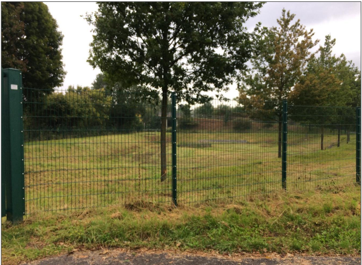
Abbildung 13: Regenrückhaltebecken am nordöstlichen Plangebietsrand
