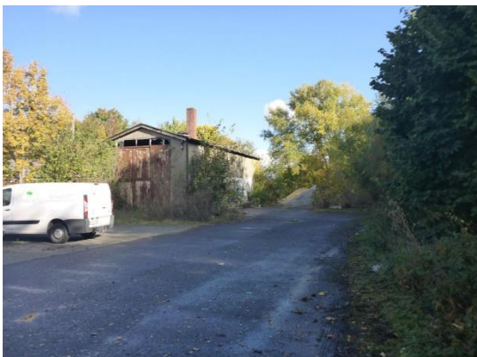
Abb. 8 Lagergebäude im Norden.
