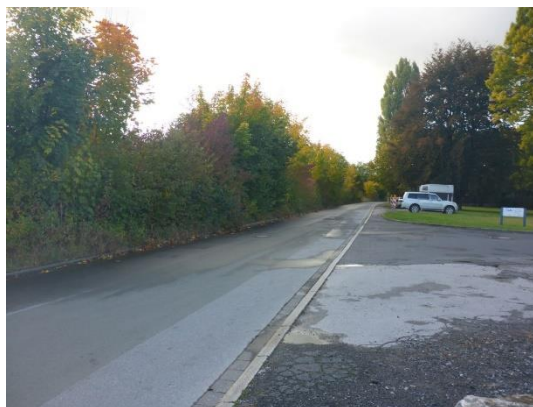
Abb. 13 Blick von Osten auf die Industrie- straße.
