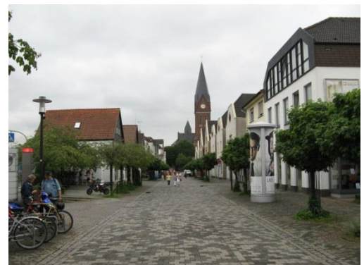
Jenseits des innerstädtischen Rundlaufs sinkt die Passantenfrequenz deutlich ab
