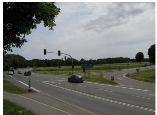
Die Abfahrt mündet auf die Bundesstraße B1. Im Kreuzungsbereich regelt eine Ampelanlage den Verkehrsfluss
