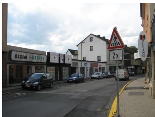
Die Kaiserstraße befindet sich in einem desolaten baulichen Zustand
