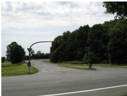
Die kombinierte Zu- und Abfahrt der Anschlussstelle „Werl-Zentrum“ der A445 bei Fahrtrichtung Norden
