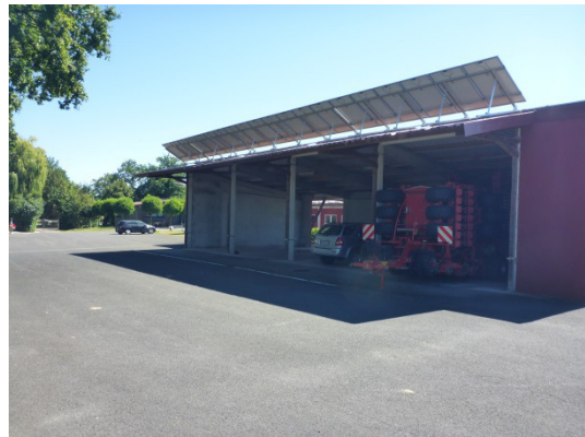
Abb. 7 Maschinenhalle, die im Zuge der Neuordnung der Hofstelle abgebrochen werden soll.
