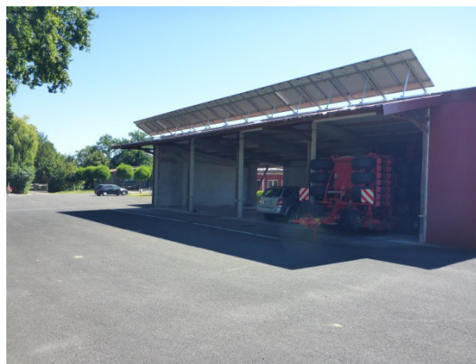
Abb. 6 Maschinenhalle die im Zuge der Neuordnung der Hofstelle abgebrochen werden soll.
