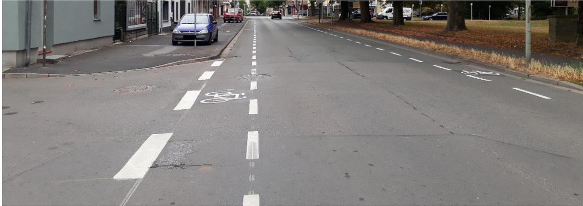
*Abbildung 57: Hammer Straße nach der Markierung eines Schutzstreifens*
