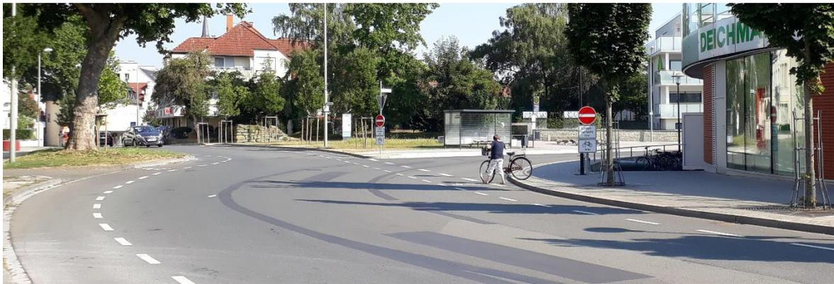
Abbildung 51: Fehlende Bordabsenkung an der Fahrradparkanlage vor dem Einkaufszentrum
