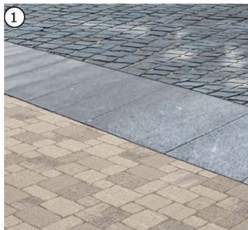
1 Einfassung: Großformatplatten (Granit) Grau
