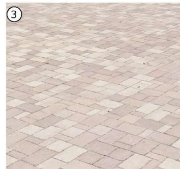
3 Hauptbewegflächen: Mehrsteinverband (Betonstein) Helle Farbe
