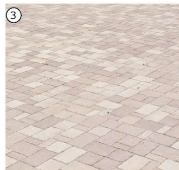
3 Hauptbewegflächen: Mehrsteinverband (Betonstein) Helle Farbe
