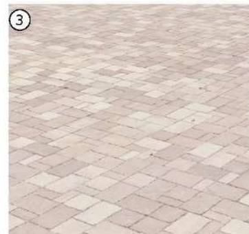
3 Hauptbewegflächen: Mehrsteinverband (Betonstein) Helle Farbe
