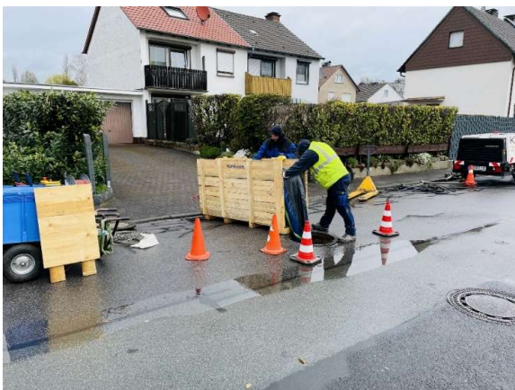
Einzug des Inliners
