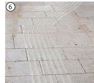
6 Blindenleitsystem: gefräst
