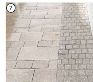
7 Traufstreifen: Natursteinpflaster aus Bestand (Granit)
