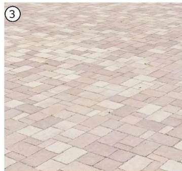
3 Hauptbewegflächen: Mehrsteinverband (Betonstein) Helle Farbe
