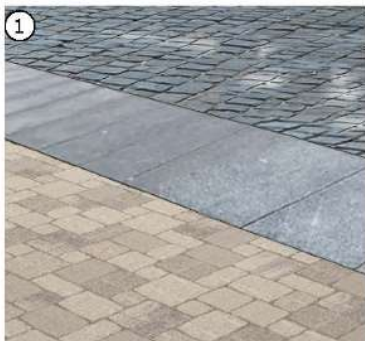
1 Einfassung: Großformatplatten (Granit) Grau
