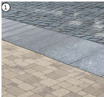
Einfassung: Großformatplatten (Granit) Grau
