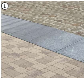
1 Einfassung: Großformatplatten (Granit) Grau
