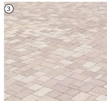
3 Hauptbewegflächen: Mehrsteinverband (Betonstein) Helle Farbe
