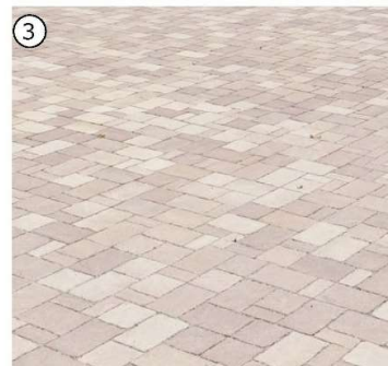
Hauptbewegflächen: Mehrsteinverband (Betonstein) Helle Farbe
