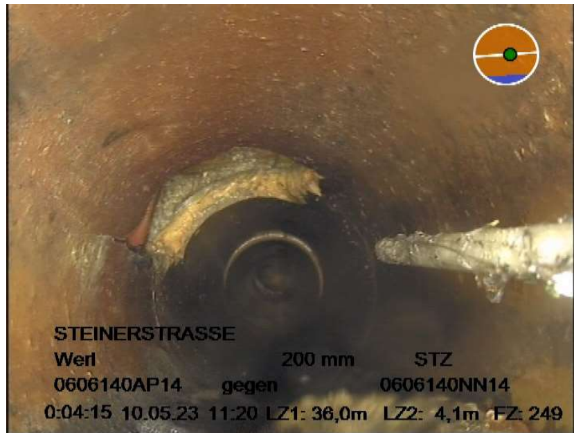
Einragende Stützen
