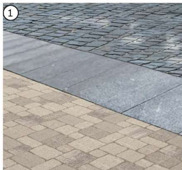
Einfassung: Großformatplatten (Granit) Grau
