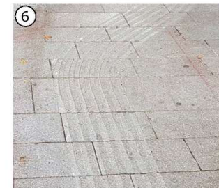
6 Blindenleitsystem: gefräst
