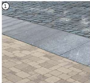
Einfassung: Großformatplatten (Granit) Grau
