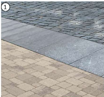
1 Einfassung: Großformatplatten (Granit) Grau
