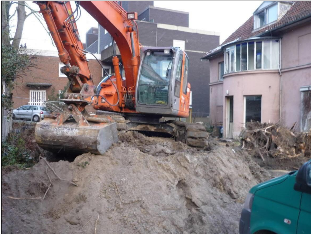
Abbildung 9: Material, Unwegsamkeiten, Baugeräte in der Sondierfläche
