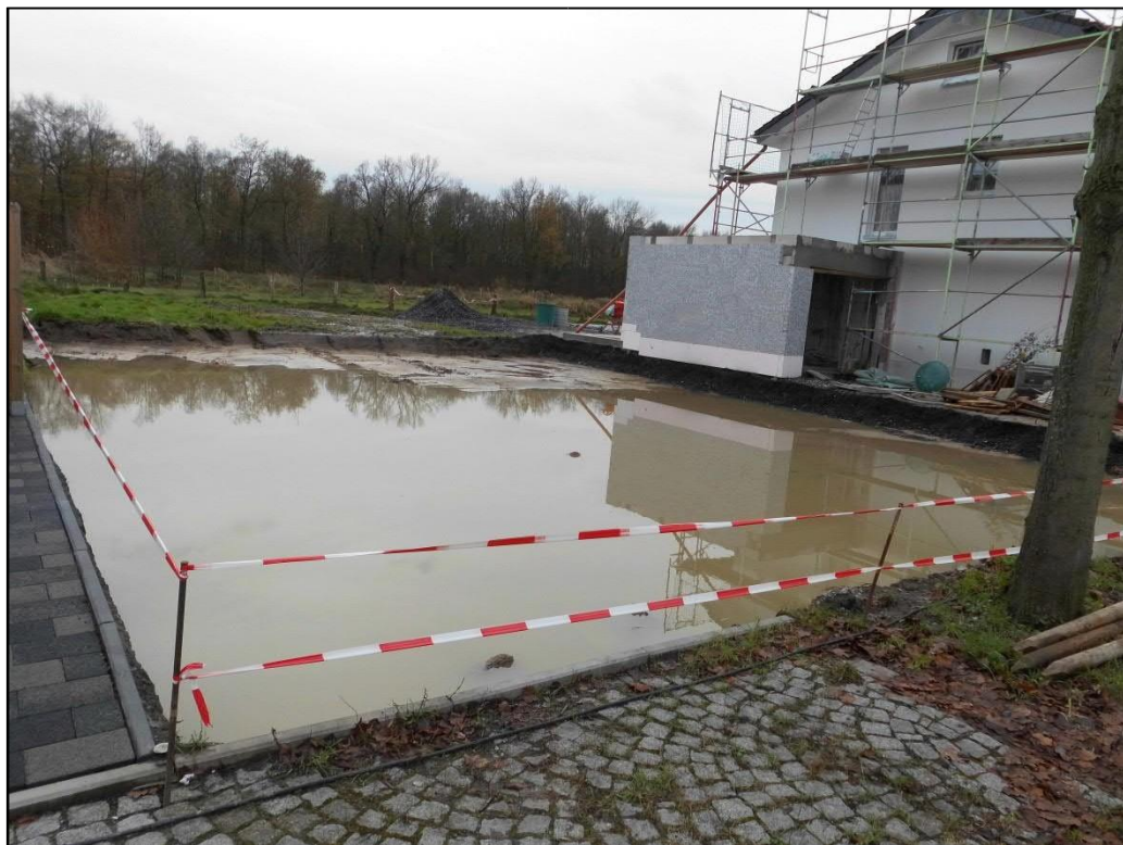
Abbildung 4: Hoher Wasserstand in Baugrube
