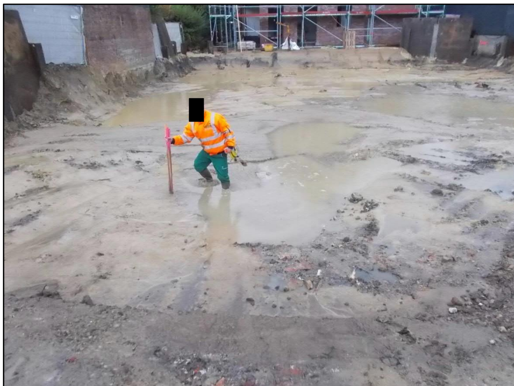
Abbildung 2: Verschlammte Sondierfläche, Bauschutt
