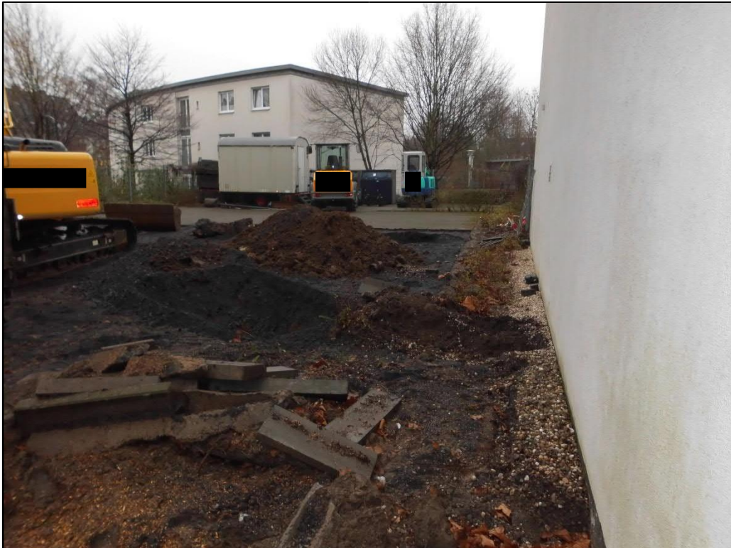
Abbildung 8: Bauschutt, Unwegsamkeiten, Baugeräte in der Sondierfläche
