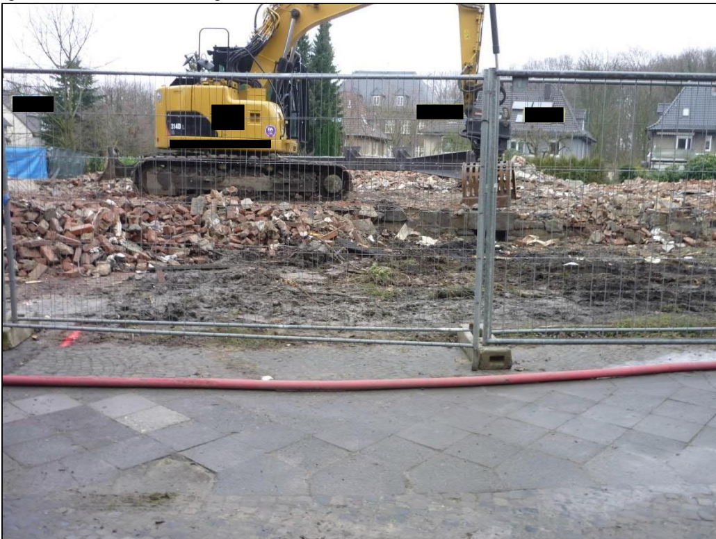
Abbildung 6: Bauschutt, Unwegsamkeiten und Baugeräte in der Sondierfläche
