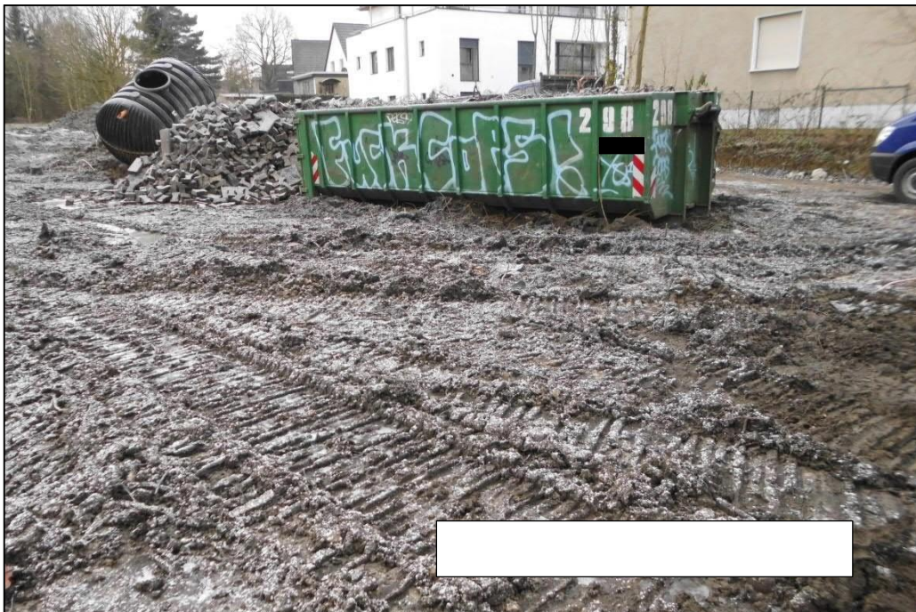
Abbildung 12: Eisenhaltige Objekte, Bauschutt in der Sondierfläche
