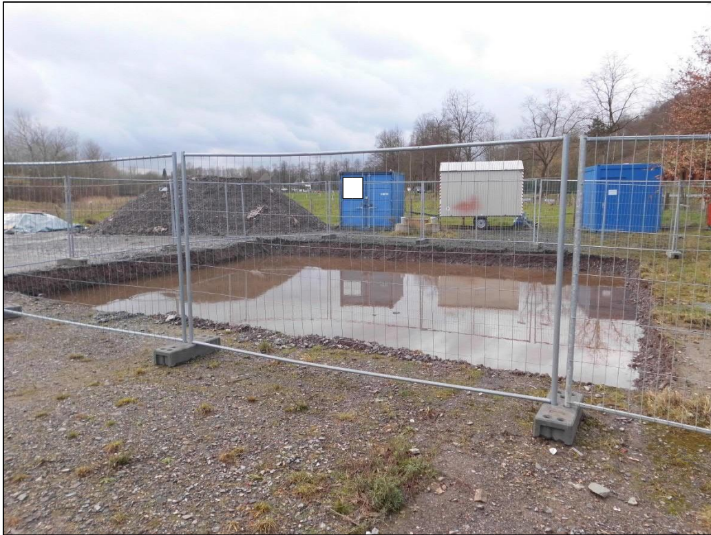
Abbildung 3: Hoher Wasserstand in Baugrube
