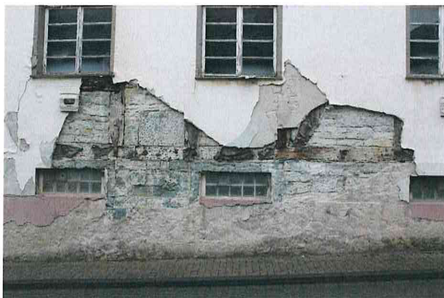
Abbildung 8: Haus Fredrich & Neuschäfer, Mittelalterliche Wand, darüber Fachwerk mit Grünsandsteinausfachung
