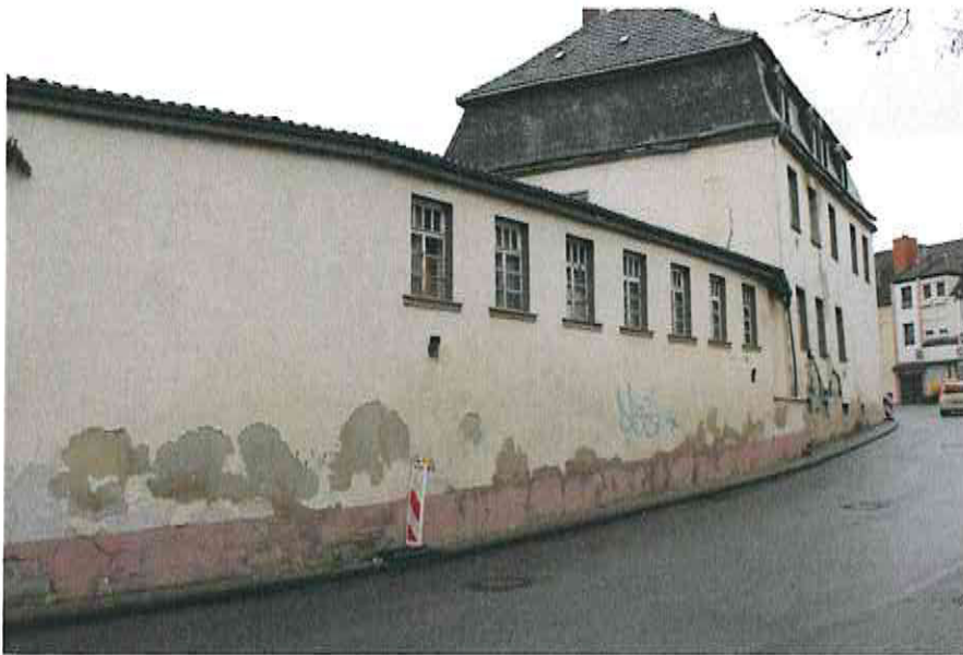
Abbildung 98: Kämperstraße, die dem Verlauf der alten Befestigung folgt; diese ist wahrscheinlich im Mauerwerk enthalten.
