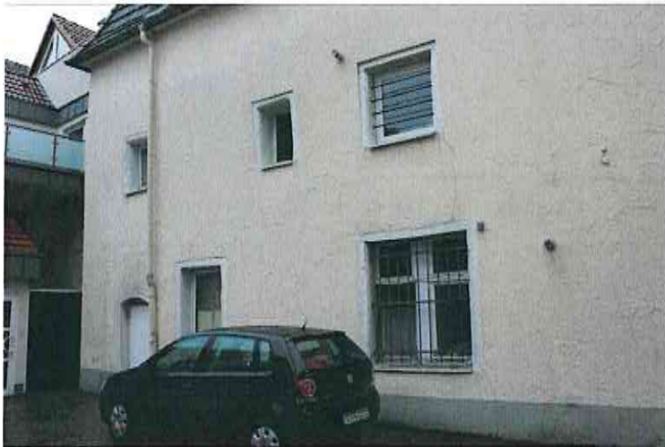
Abbildung 12: ehem. Haus Feldheim, Westseite mit mittelalterlichen Fensterrahmen
