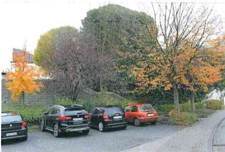
Abbildung 10: Das „dritte Gebäude“ mit Mansarddach und Gewölbekeller, unter Efeu verschwunden; daneben die erneuerte Mauer
