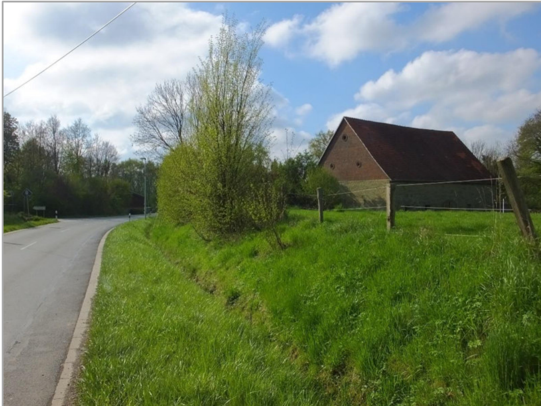
Abbildung 7: Blick von der Kreisstraße auf die Scheune aus Grünsandstein im Plangebiet
