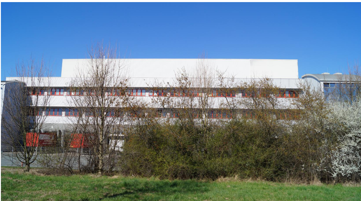
Abb. 34: Ansichten der bestehenden Hochregallager der Firma A.T.U. (Quelle: eigene Aufnahmen)
