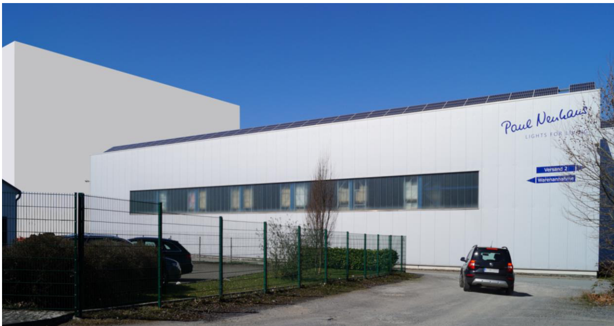
Abb. 21: Blick von Industriestraße auf Zufahrt zum Firmengelände und das geplante Hochregallager (Quelle: eigene Darstellung)
