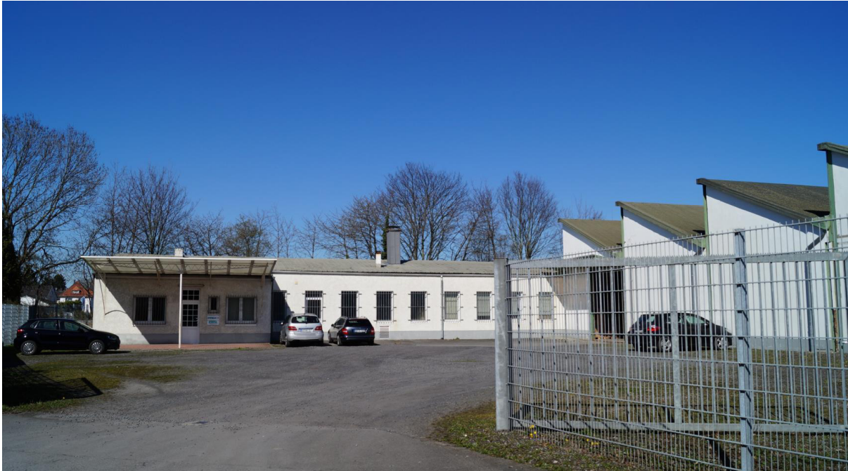
Abb. 22: Blick von An der Kleinbahn (Quelle: eigene Aufnahme)
