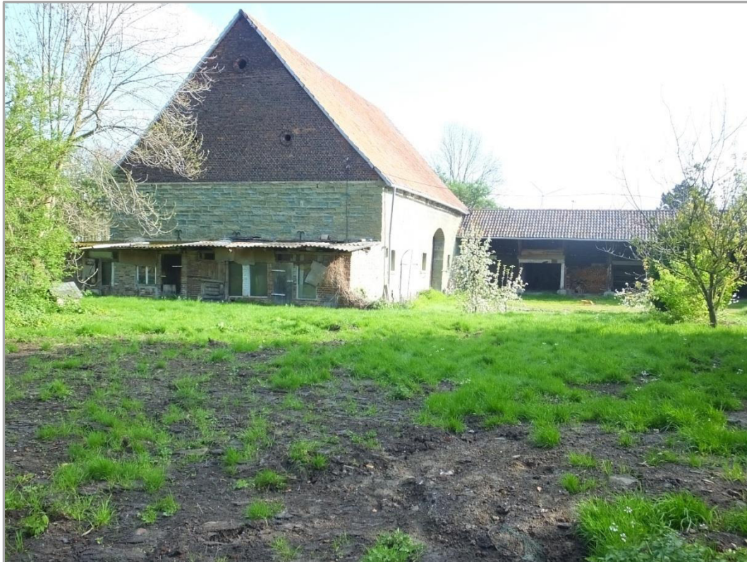
Abbildung 3: Blick auf die Scheune und die Remise im Plangebiet
