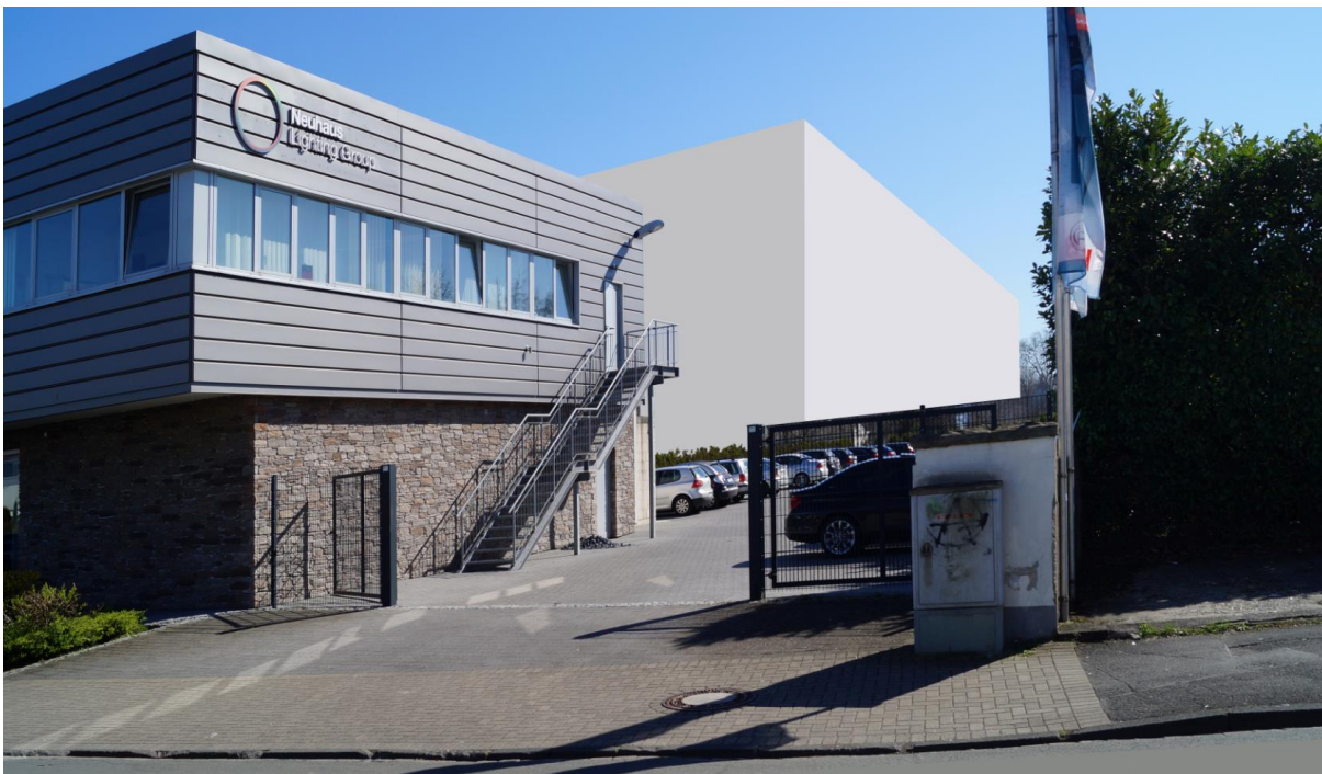
Abb. 17: Blick auf Neuhaus Lighting Group Firmengelände und Hochregallager, Olakenweg (Quelle: eigene Darstellung)
