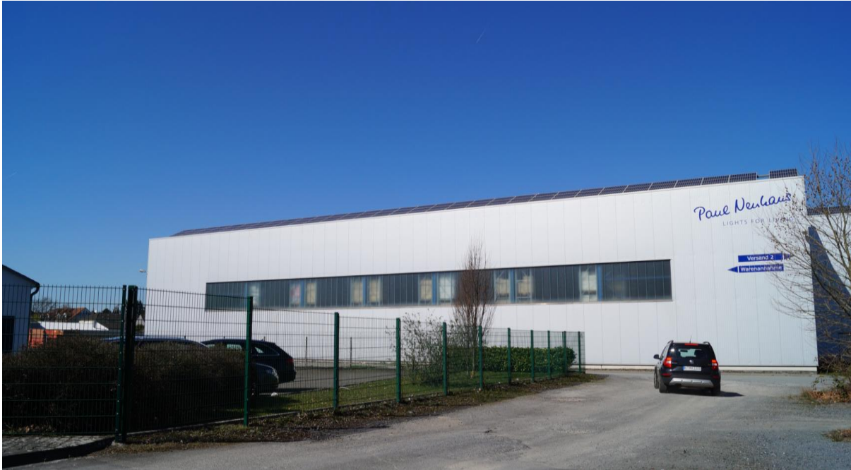
Abb. 20: Blick von Industriestraße auf Zufahrt zum Firmengelände (Quelle: eigene Aufnahme)
