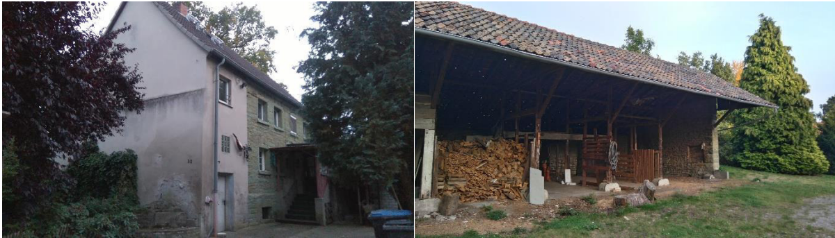
Abbildung 4: Baufälliges Wohnhaus (links) und Remise (rechts)
