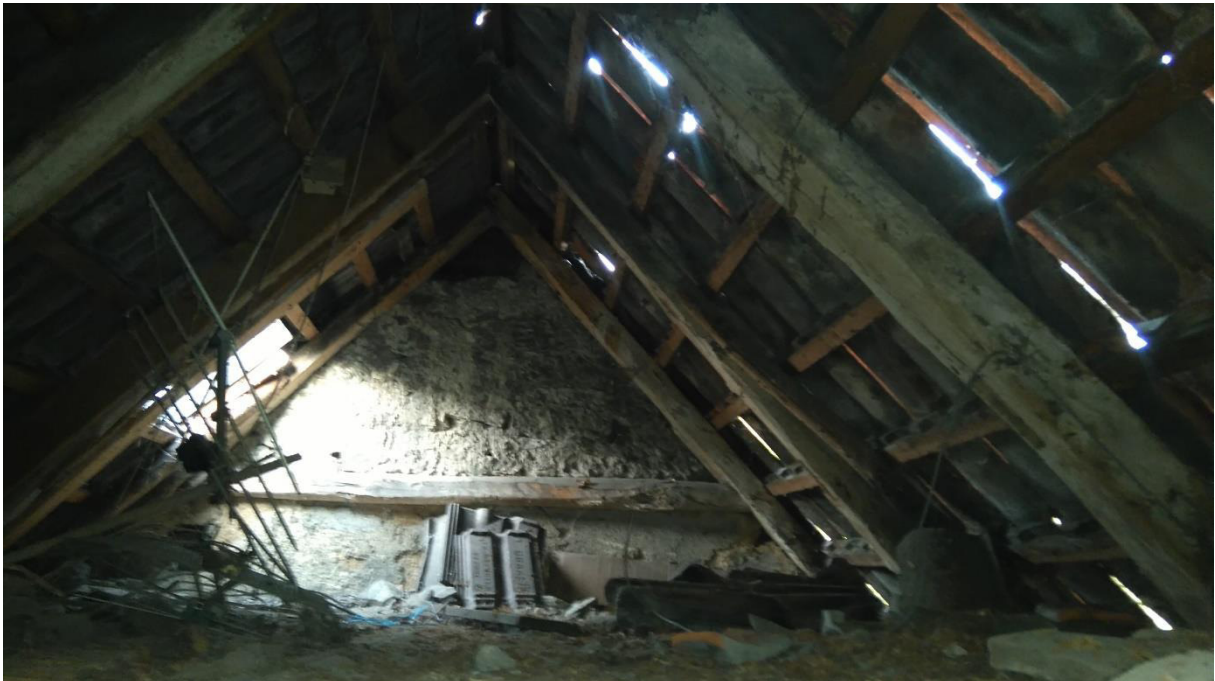
Abbildung 9: Dachboden des Wohnhauses. Lichteinfall verhindert eine Quartiereignung für Fledermäuse
