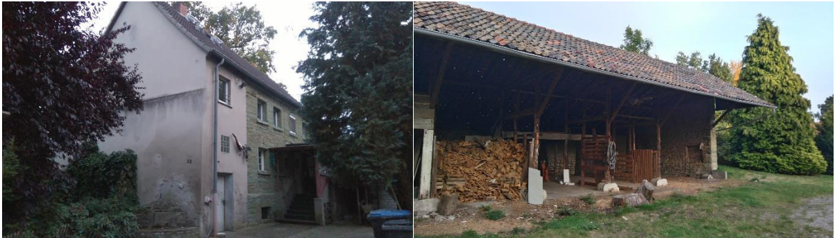
Abbildung 4: Baufälliges Wohnhaus (links) und Remise (rechts)
