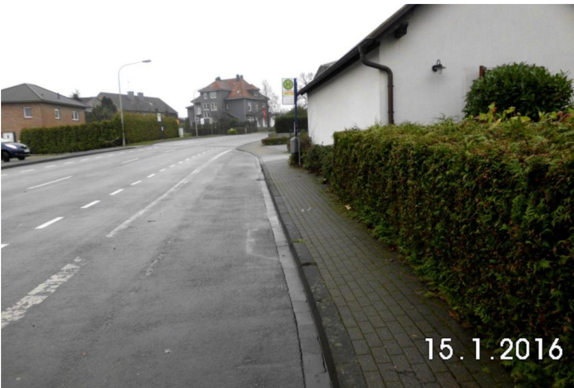
Bild 6: Bushaltestelle Neheimer Straße (westliche Fahrbahnseite)
