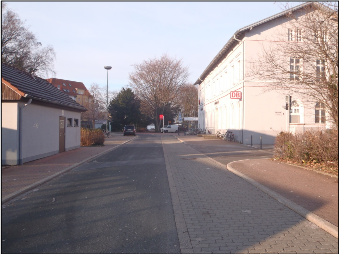
Abbildung 3: Südlicher Bereich des Plangebietes - Bahnhofsgebäude mit Vorplatz
